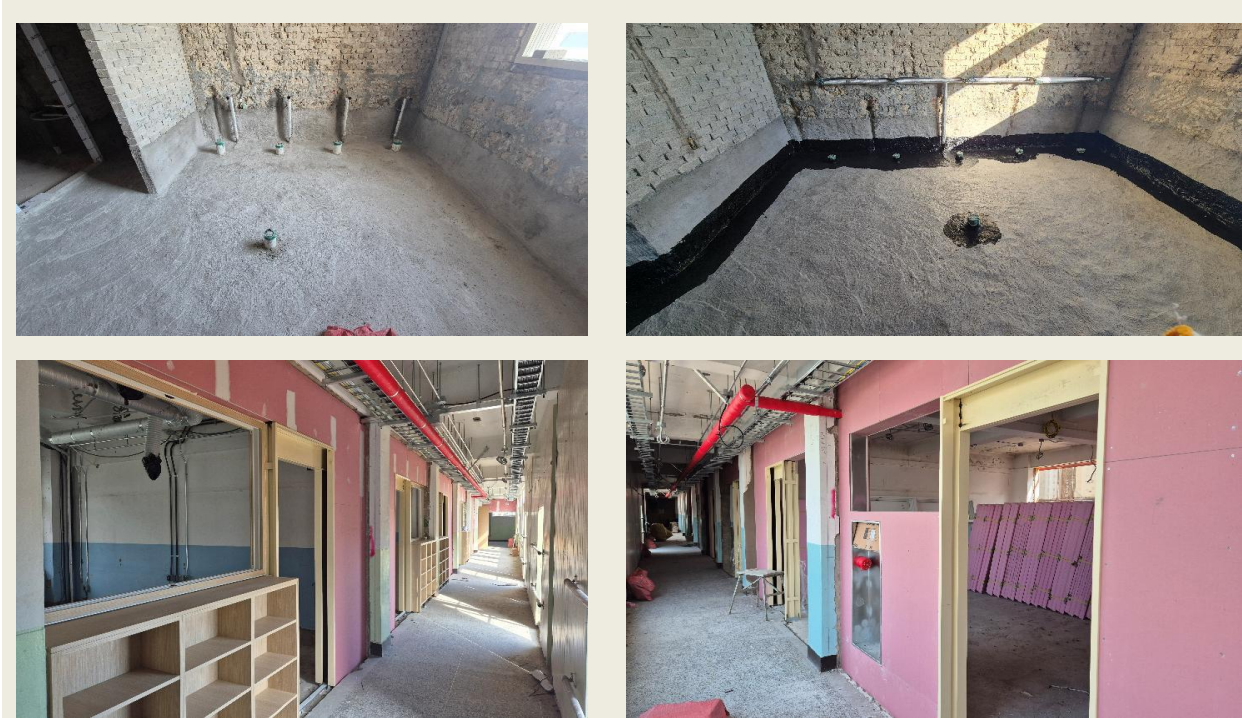
공사 추진 단계(방수, 출입문공사)
