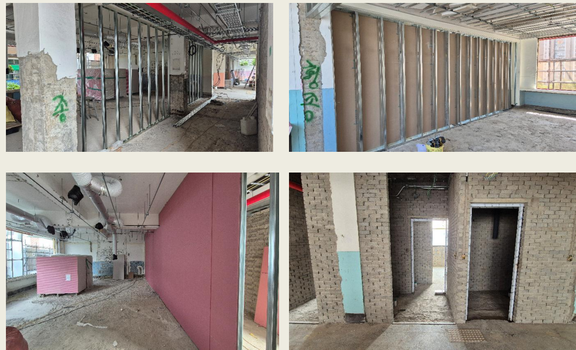
공사 추진 단계(경량, 조적공사)
