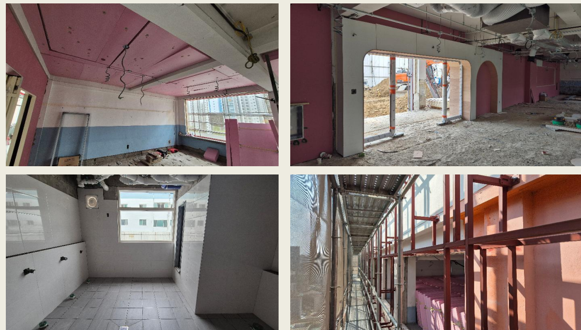
공사 추진 단계(단열, 수장, 타일공사)
