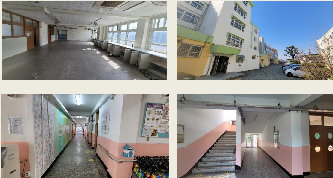
공사 추진 단계(철거 전)
