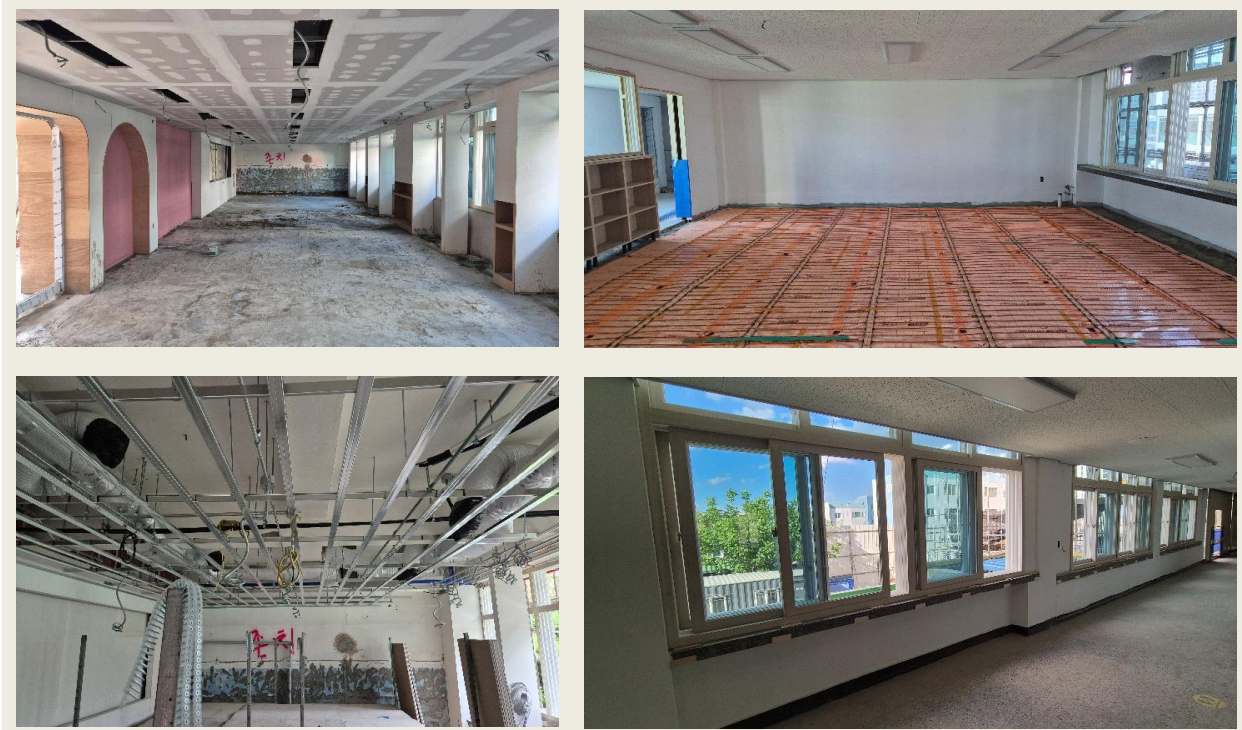
공사 추진 단계(창호, 금속공사)
